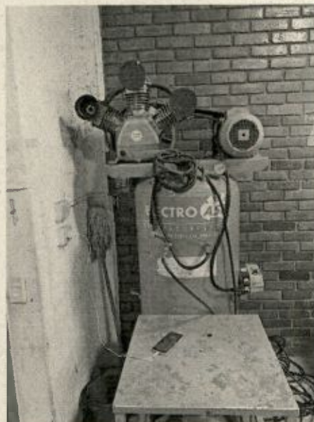
Zonas eléctricas sin demarcación ni señalización cables en suelo.
